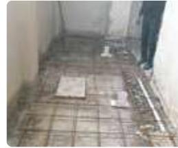
1 Lay Metal Mesh (BRC)
